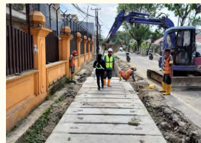
PEKERJAAN PROYEK DRAINASE Jalan Hayam Wuruk & Amir Hamzah
