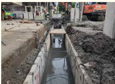
PEKERJAAN PROYEK DRAINASE Perkotaan Jalan Sutomo Ujung
