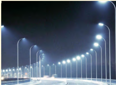
PEKERJAAN PEMBUATAN LAMPU PJU Penerangan Jalan Umum Meureubo - Aceh
