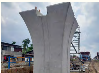
PEKERJAAN STRUKTUR JALAN LAYANG Kereta Api Medan - Binjai
