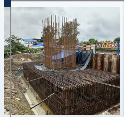
PEKERJAAN PONDASI DAN STRUKTUR
