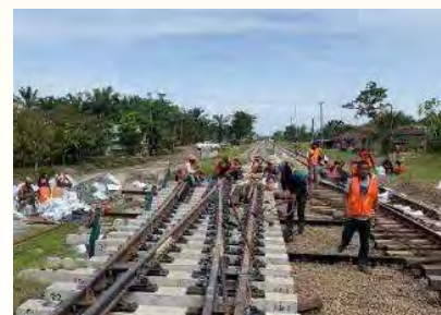
PENYELESAIAN PEKERJAAN LINTAS Kereta Api Binjai - Besitang
