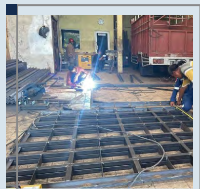
FABRIKASI STRUKTUR KONSTRUKSI BAJA
