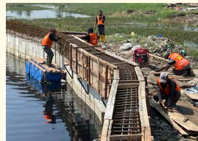
PEKERJAAN BETON CACING BEAM Kel. Martubung Kec. Medan Labuhan
