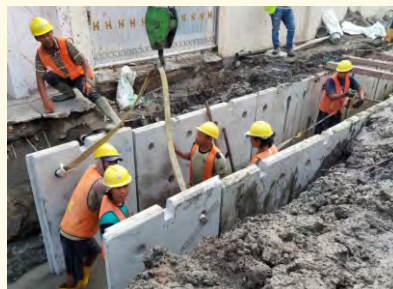
PEKERJAAN PROYEK DRAINASE Jalan Rel Kruntung Medan, Kota Medan
