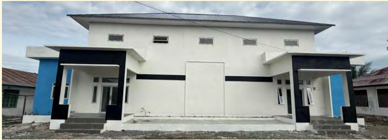
PEKERJAAN BANGUNAN GEDUNG Gedung Aula Serbaguna Meureubo - Aceh
