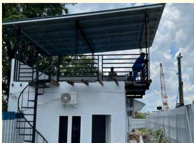
PEKERJAAN DIREKSI KIT Proyek Jalan Layang Kereta Api
