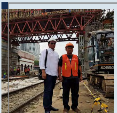
KONSTRUKSI JEMBATAN DAN REL KERETA API
