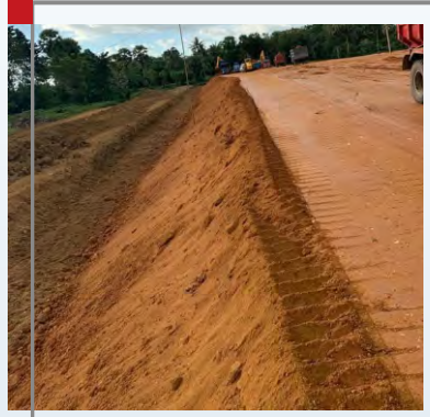
PEKERJAAN CUT & FILL TANAH & Pengerukan
