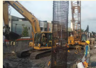
PEKERJAAN PEMBESIAN BORE PILE Jalan Layang Kereta Api Medan - Binjai
